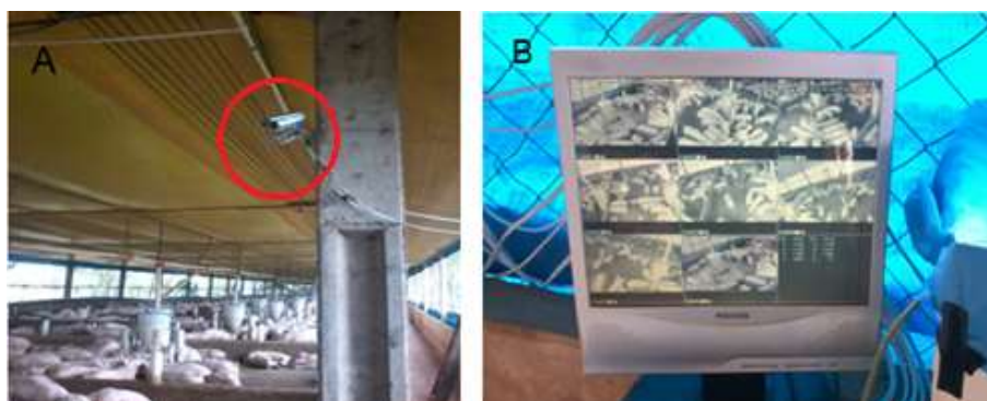
Figura 4. Câmeras de vídeos instaladas na parte superior das baias (A) e televisor de LCD receptor das imagens (B). Fonte: arquivo pessoal.
